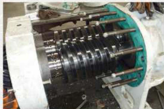
过流零件表面激光喷涂 消除含沙输送对零件磨蚀的隐患
